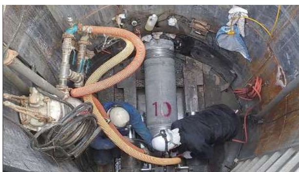
下水道工事の様子
