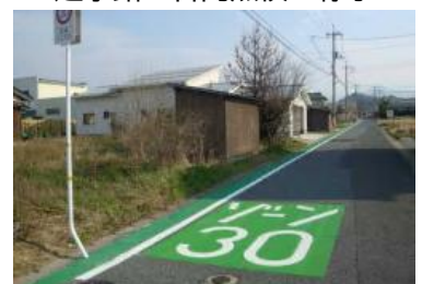
ゾーン30の路面標示
