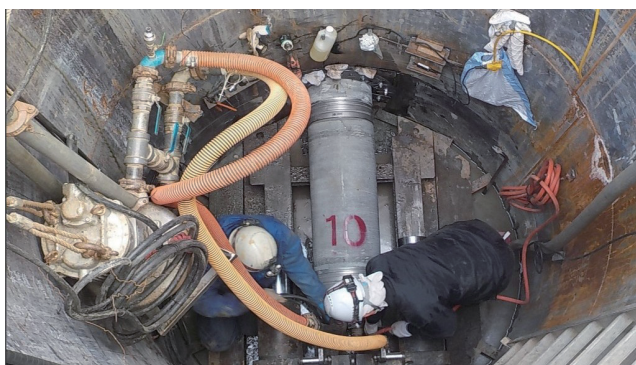
下水道工事の様子
