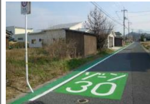
ゾーン30の路面標示
