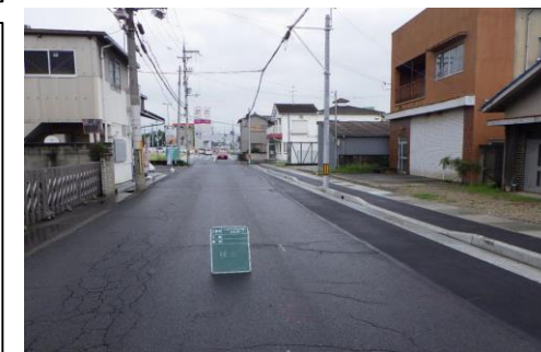
道路拡幅による歩道の設置
