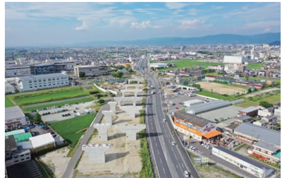
整備中の京奈和自動車道
