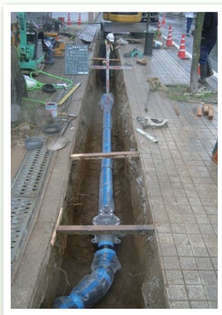
上水道の管路更新工事
