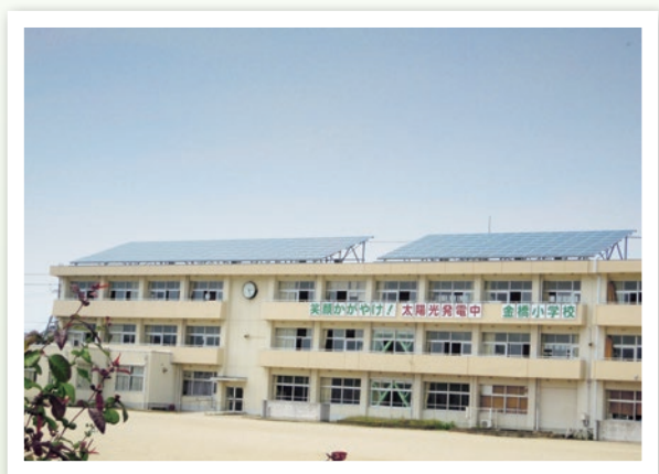
小学校校舎屋上を利用した太陽光発電
