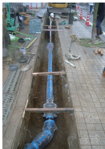
上水道の管路更新工事
