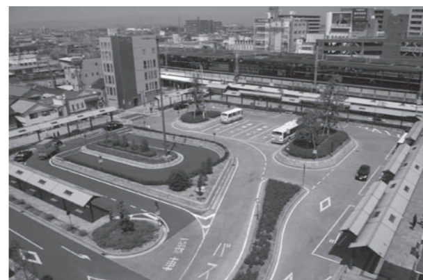
大和八木駅前の整備
