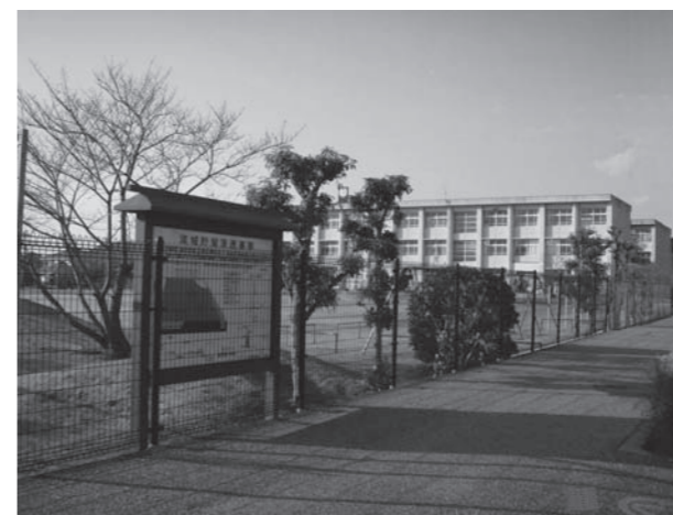
雨水貯留浸透施設
