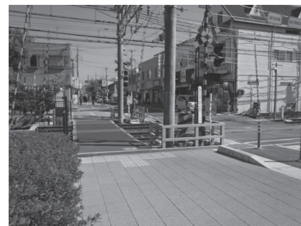
踏切道における歩道整備
