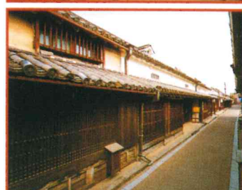
▲ 道路整備（写真上／施工前、写真下／施工後）
