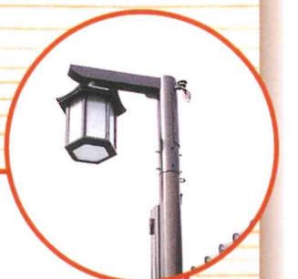
街灯柱(低圧分岐箱 内蔵型)の美装化 ▼
