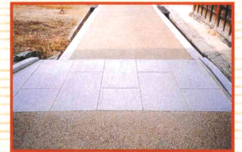
▼ 石橋・水路の整備
