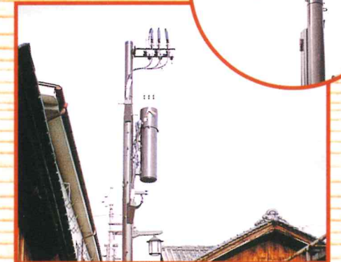
▼トランス柱の美装化
