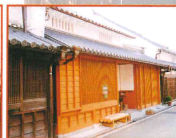
▲ 建造物修景事例（写真左／施工前、写真右／施工後）
