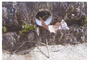
写真-5 排水パイプの中
