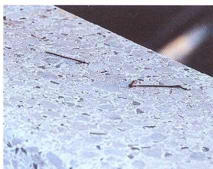
手すり上に残る脚
