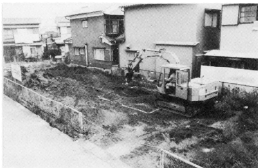
写真10 調査風景（表土剥ぎ取り）
