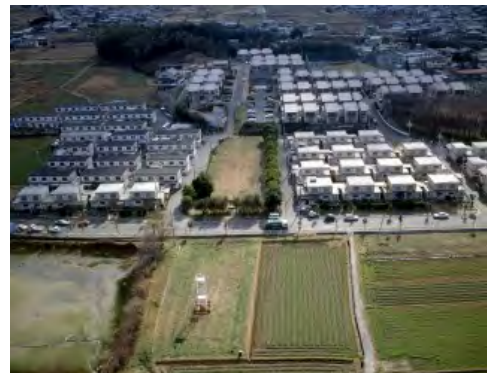
写真 20 藤原京跡朱雀大路跡(北から)
