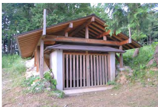
写真 47 平成 25 年に設置した石室保護のための覆屋
