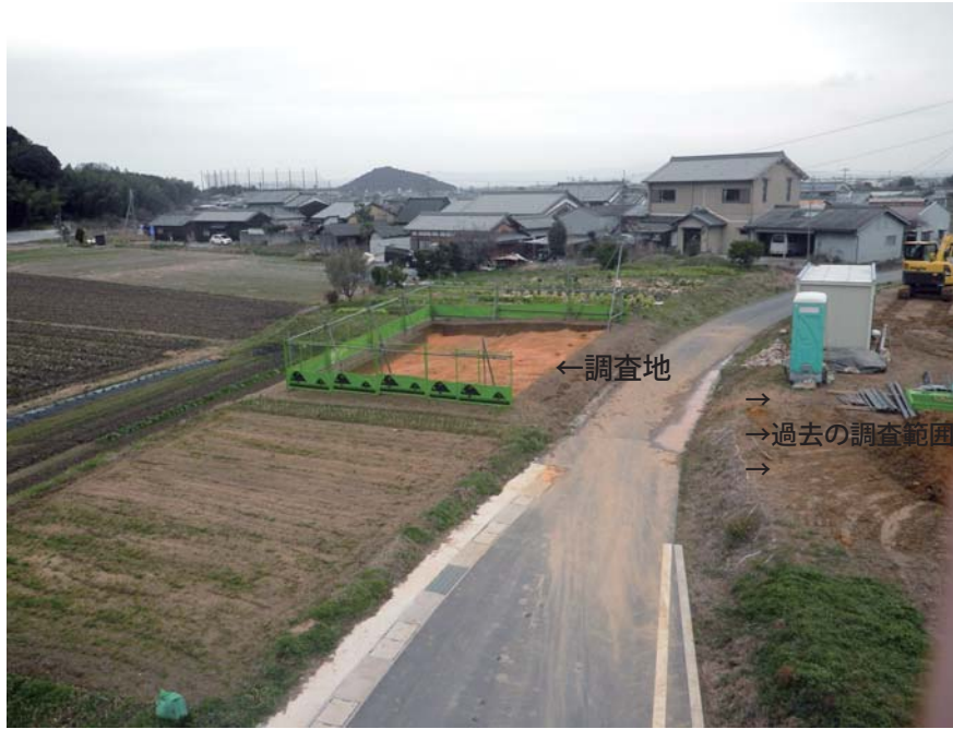
調査地中景 (南東から)
