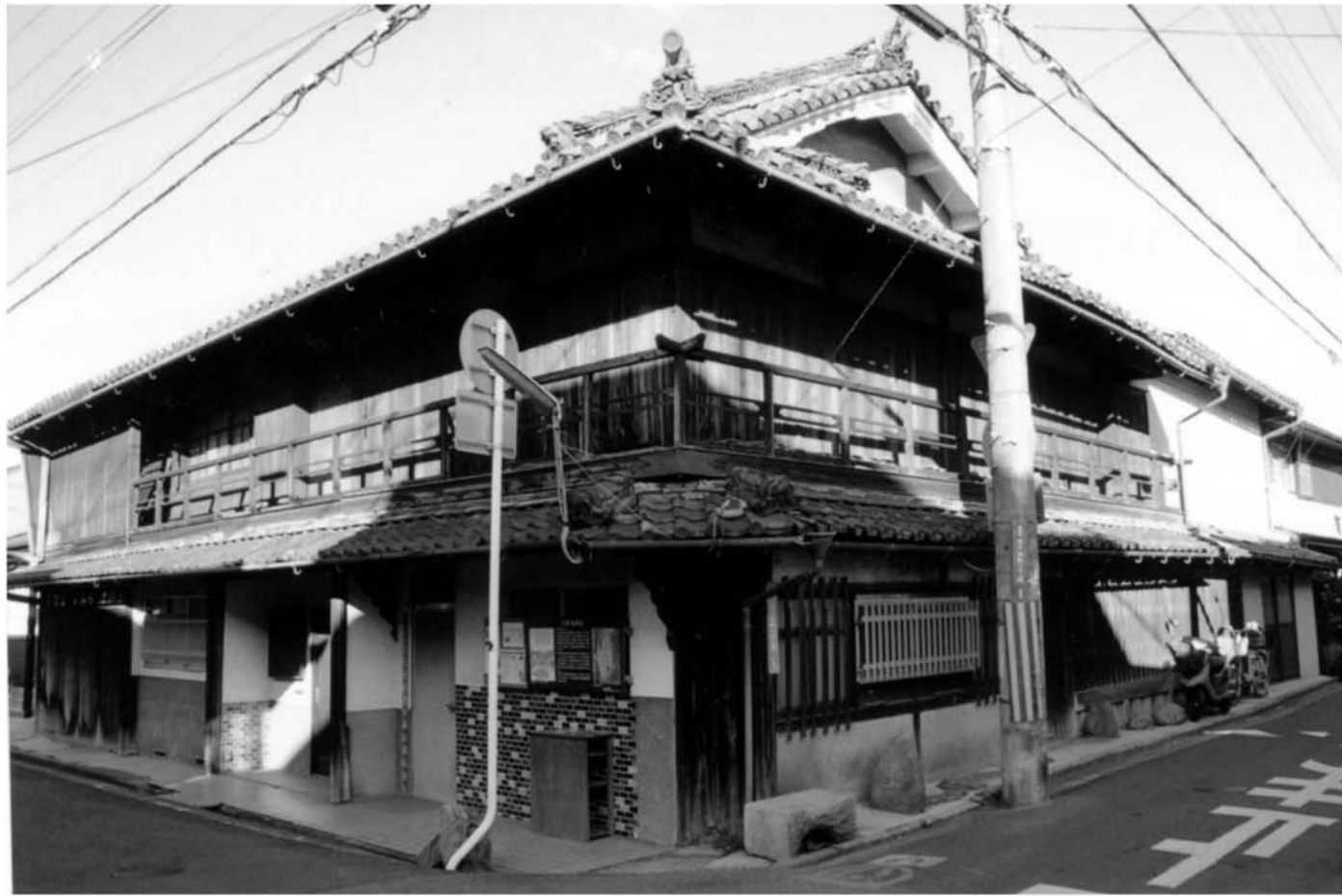
建物外観（南西から・修理前）
