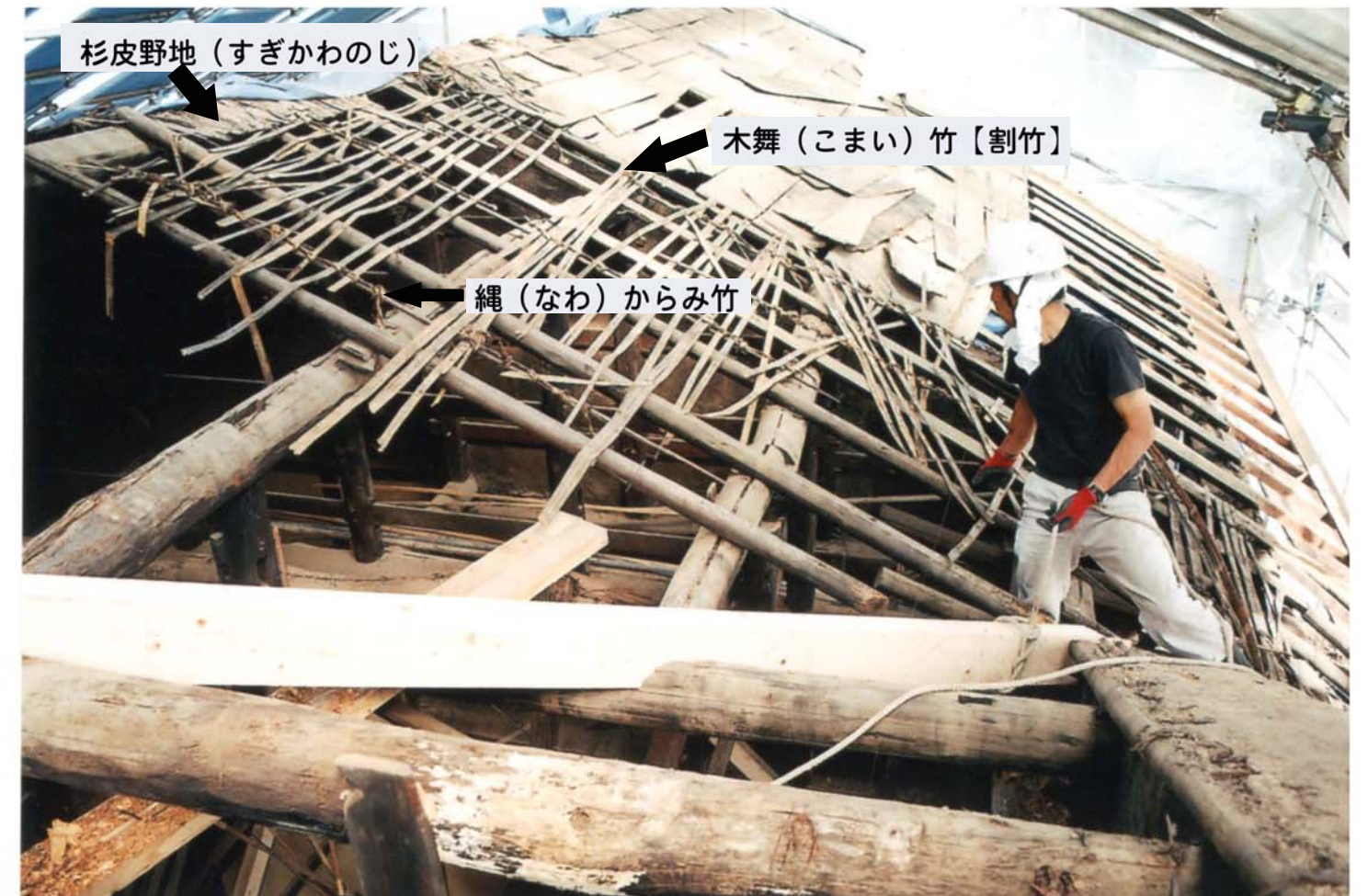
屋根下地の様子（角屋南面）
