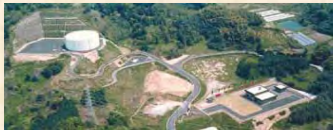
完成当時の一町配水場（平成元年）
