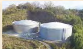
はいすいち 配水池(平成30年)
