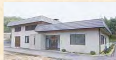
かしはら 橿原ポンプ場(注)
