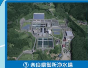
③ 奈良県御所浄水場
