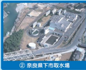
② 奈良県下市取水場
