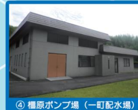
④ 橿原ポンプ場 (一町配水池)
