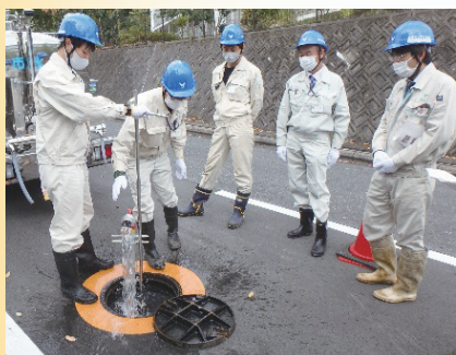
令和3年度緊急時初動給水訓練の様子
