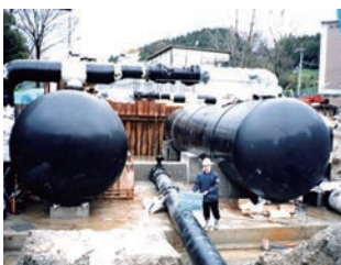
耐震性貯水槽 (設置中のようす)
