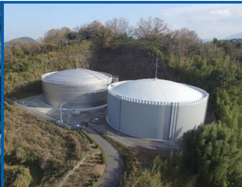
現況 増設配水池(左) 補修後の配水池(右)
