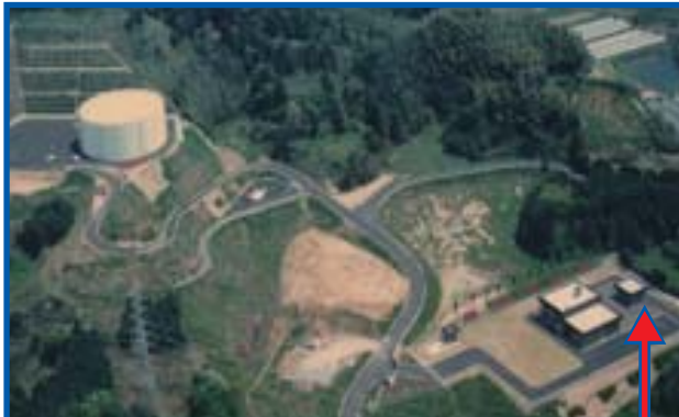
平成元年頃の一町配水場(左 配水池 右 ポンプ施設)
