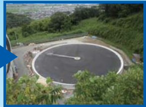
基礎工事完了
