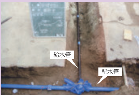
水道メーターと給水管への分岐部分
