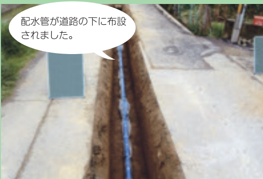
道路に配水管を布設している様子
