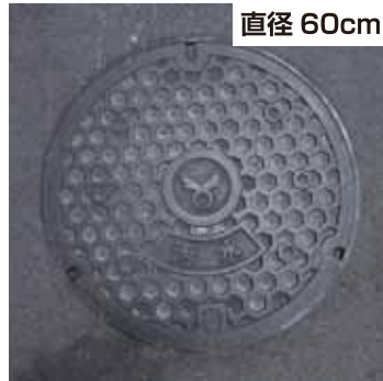
① マンホールの蓋 (一例)
