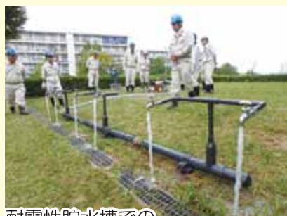
耐震性貯水槽での仮設給水栓の設置作業訓練
