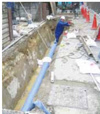
下水道本管の埋設
