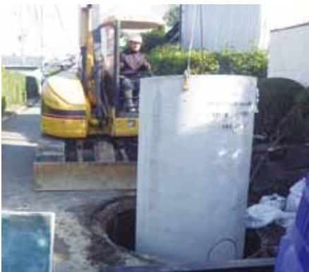
マンホールの設置作業
