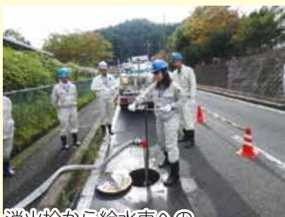
消火栓から給水車への給水作業訓練
