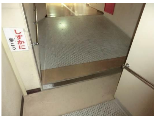
図 2-4：段差解消のためのスロープ
