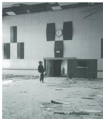
図 2-8：左) 天井材が落下した事例（講堂） 右) グランドピアノが転倒した事例（音楽室） (阪神・淡路大震災－神戸の教育の再生と創造への歩み－（神戸市教育委員会）より）
