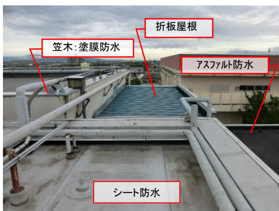
図 2-2：複数の仕上げが混在する屋上の例
