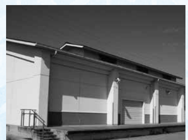
災害用備蓄倉庫 (檀原運動公園内)
