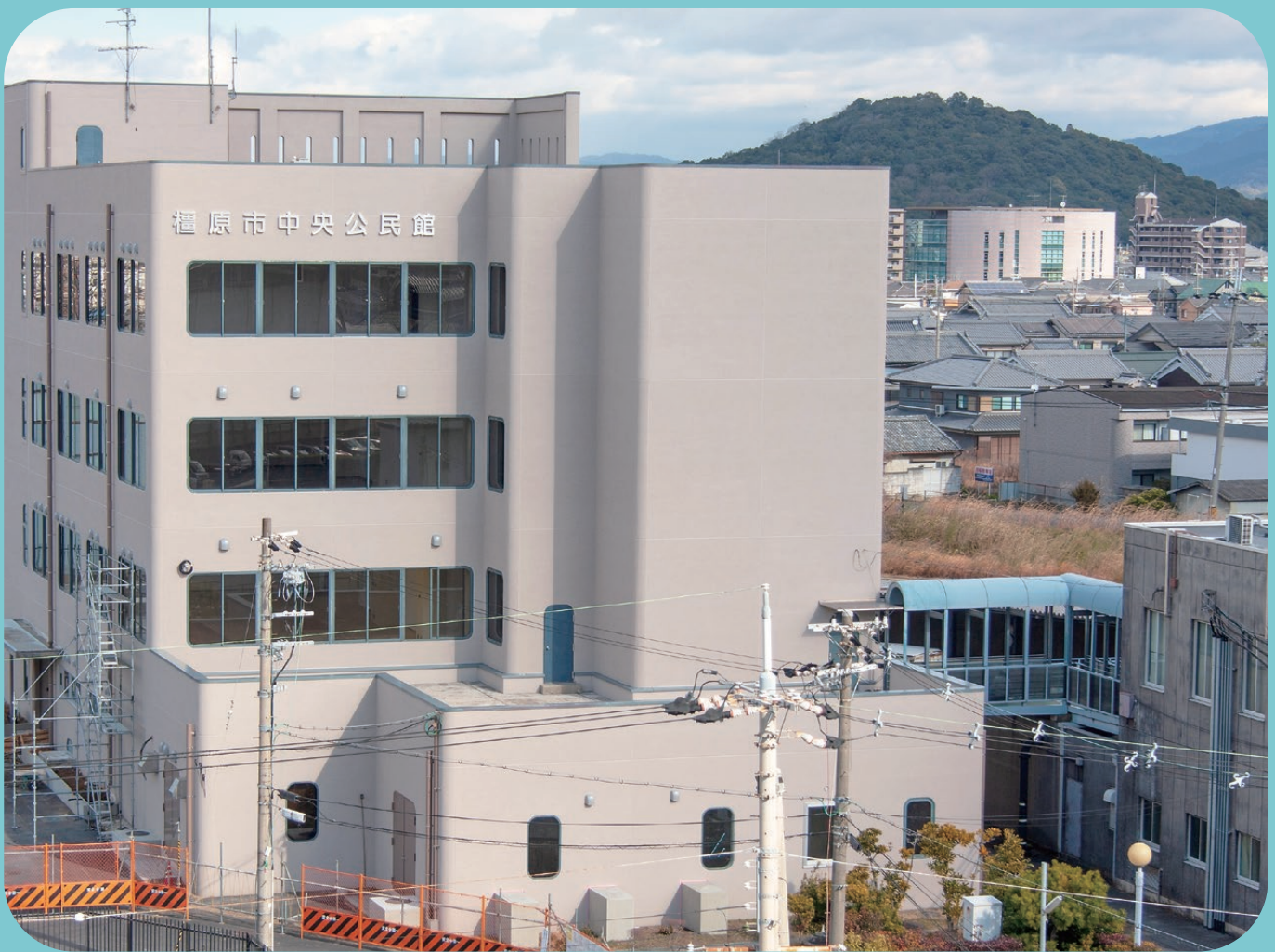
▲整備中の檜原市中央公民館
