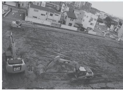
本庁舎建設予定地
