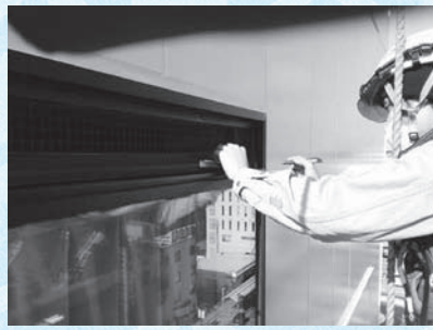
ミグランス外壁修繕
