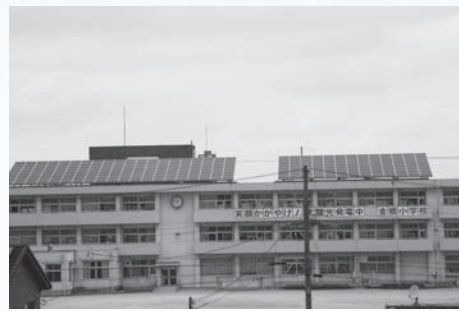
太陽光パネル（金橋小学校）
