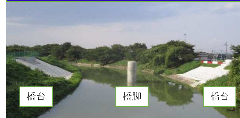
橋梁下部工事竣工 (R5.8時点)
