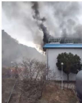
火災時の状況
