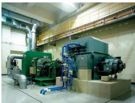
図20 クリーンセンターかしはら 蒸気タービンと発電機
