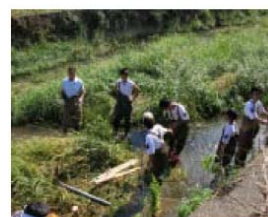
ホタルが住める川を目指した河床に木杭を打つ作業
