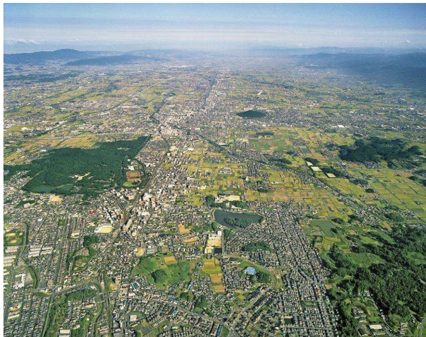
写真1 橿原市航空写真（南から）
