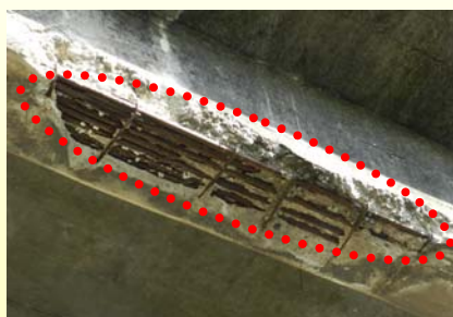
主桁の損傷（鉄筋露出）
