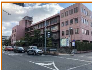
本庁舎(解体中)
