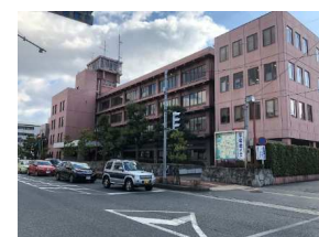
建設予定地 本庁舎敷地(東棟を残し解体済)
