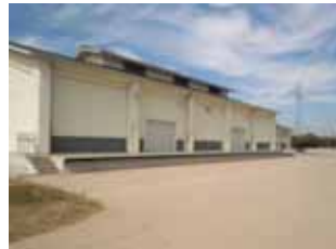
運動公園備蓄倉庫
