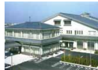
榎原市浄化センター
