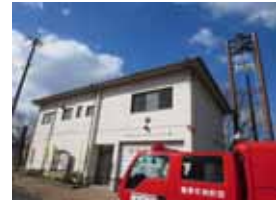
第 2 分団消防車庫
