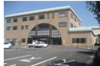
リサイクル館かしはら (処理施設)
