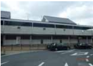
檀原神宮前駅中央口 自転車駐車場
