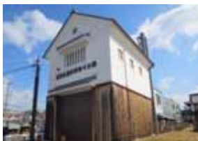
第 9 分団消防車庫
