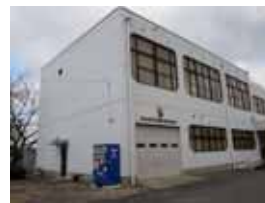
第 3 分団消防車庫
