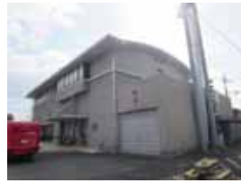
第 6 分団消防車庫
