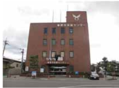
保健福祉センター（保健施設）
