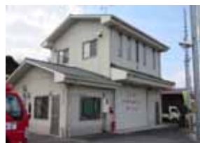
第 7 分団消防車庫
