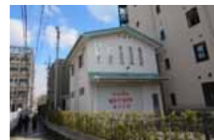
第 8 分団消防車庫
