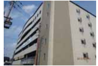
畝傍御陵前駅東 自転車駐車場
