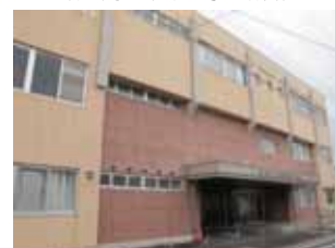
保健福祉センター (南館・事務所)
