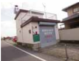
第 5 分団消防車庫
