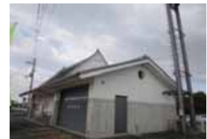
第 4 分団消防車庫
