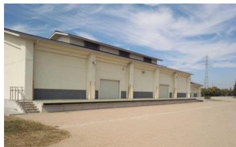
< 運動公園備蓄倉庫 >
