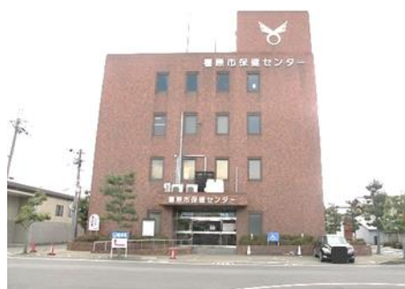
< 保健福祉センター（保健施設） >
