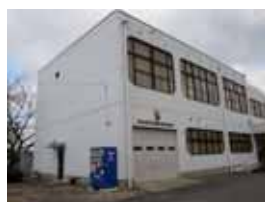
第 3 分団消防車庫
