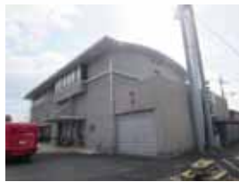
第 6 分団消防車庫
