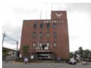
保健福祉センター (北館・事務所)
