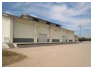
運動公園備蓄倉庫
