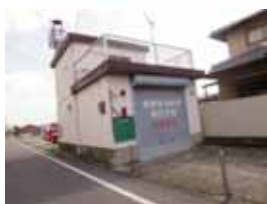
第 5 分団消防車庫
