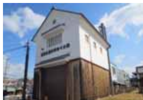
第 9 分団消防車庫
