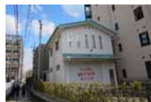
第 8 分団消防車庫
