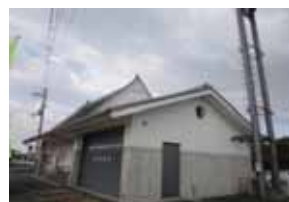
第 4 分団消防車庫
