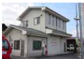
第 7 分団消防車庫
