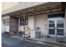
畝傍中学校 (給食室)
