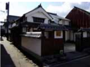
旧西町防災小屋
