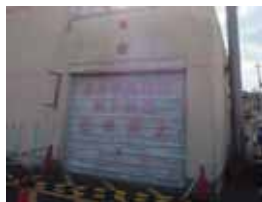
第 1 分団消防車庫
