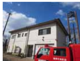
第 2 分団消防車庫
