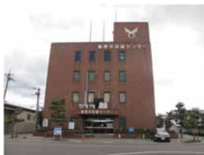
保健福祉センター（保健施設）
