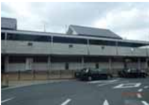
檀原神宮前駅中央口 自転車駐車場
