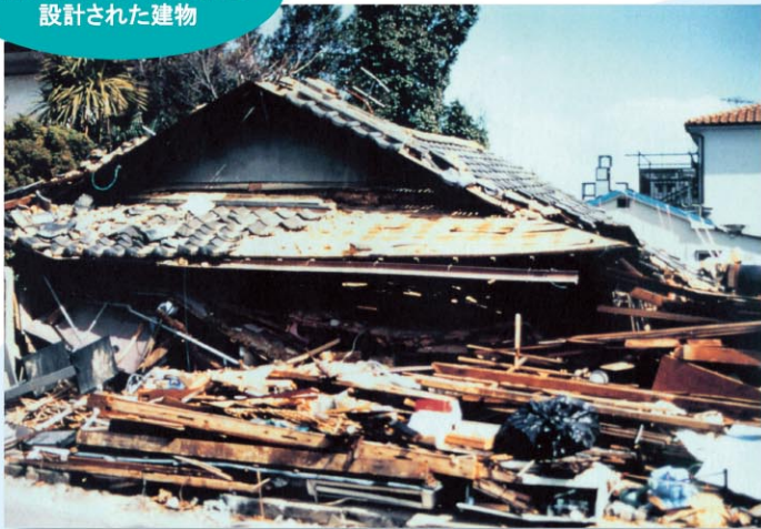
写真:「阪神・淡路大震災木造住宅震災記録図説」 (財)日本住宅・木造技術センター平成9年10月発行
