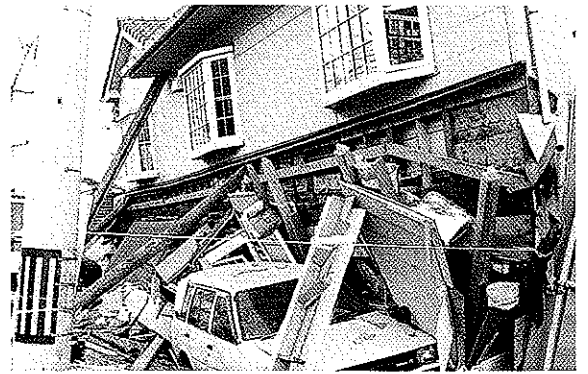
地震による被害例（阪神・淡路大震災）
