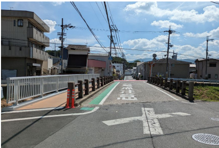
土木費／道路新設改良事業 (市道光陽西池尻線 歩行者専用橋設置)
