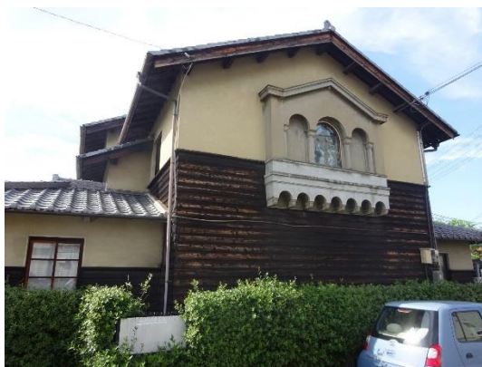
東側からの 外観
